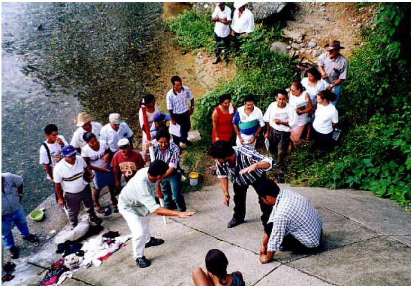
Pintando escala hidrométrica en una base de puente por miembros de la comunidad
