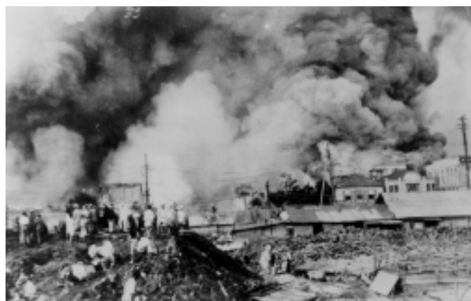
関東大震災 Great Kanto Earthquake, 1923 写真提供: 共同通信社 Photo: Kyodo News
