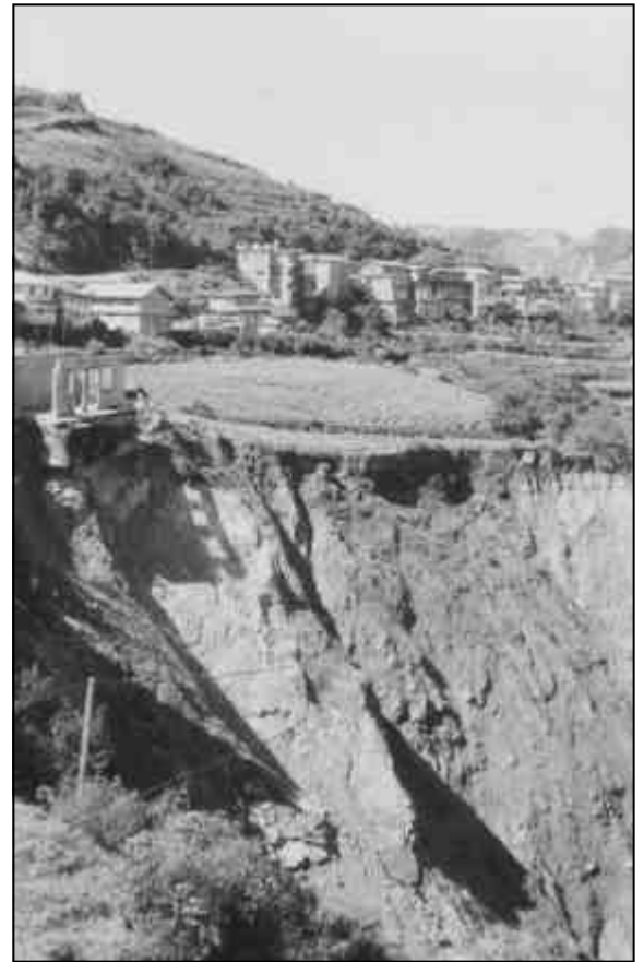
L'érosion provoque des dommages aux infrastructures et propriétés agricoles
